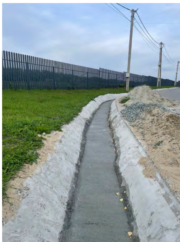
Фото 8. Заливка бетонного дна для лотка
